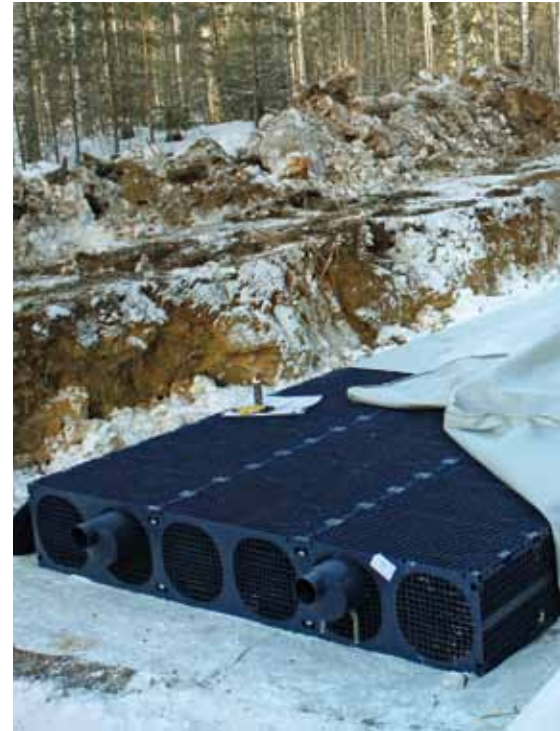
Hulevesikasetin asennus. Rakenne eristetään ympäröivästä maaperästä suodatinkankaalla.
