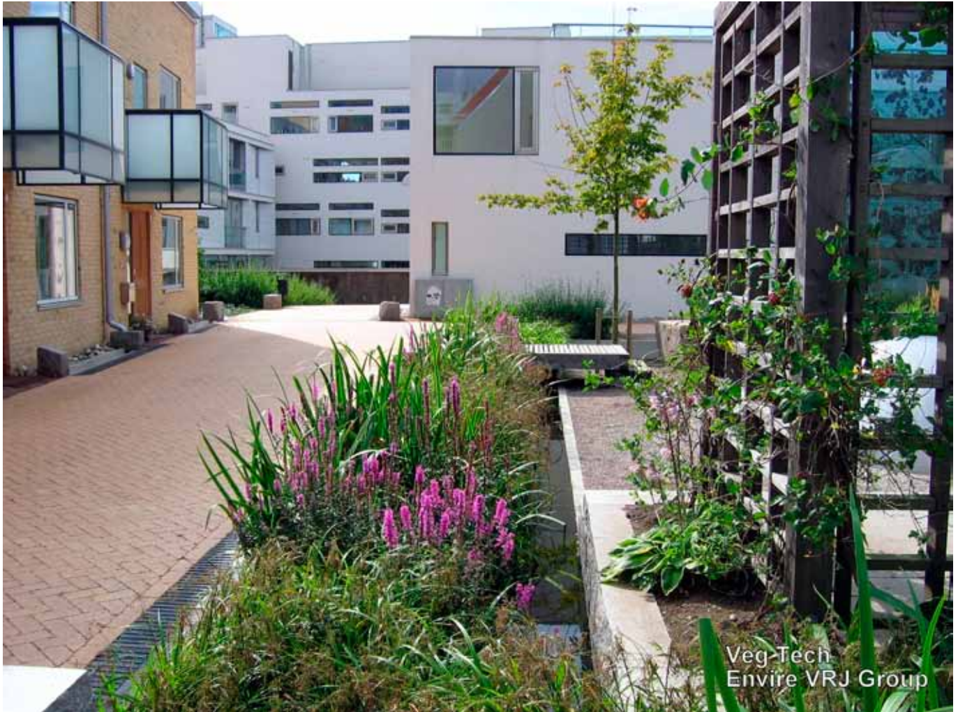
Katuvesien imeytyspainanne. Kiveyksessä olevasta aukosta vedet johtuvat painanteeseen (Vegtech/Envire VRJ Group 2009).
